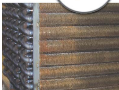
Vue en coupe du détail d'un tube alleté
